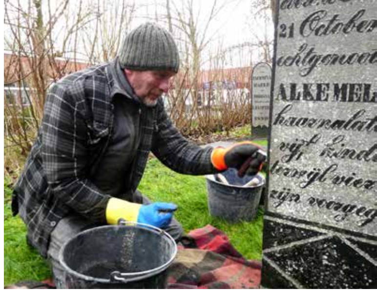
De steenhouwer vult een uitgeslepen scheur.
