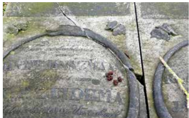
Scheur ontstaan door slechte ligging.
