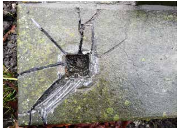
Verroest ijzer wordt weggehaald.
