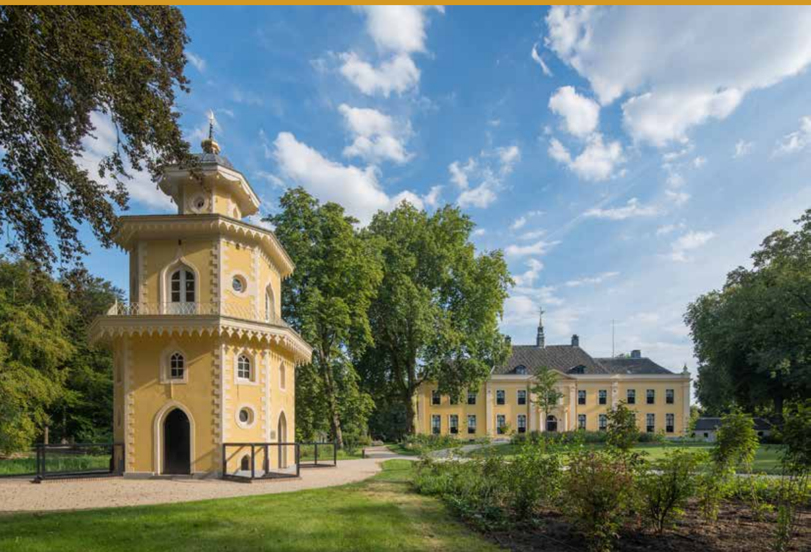
Huis Landfort in Megchelen, Gelderland. Foto Cor Bouwstra
