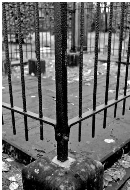
OLST, GESCHILDERD HEKWERK IS MET LOOD WEER VASTGEZET IN DE HARDSTENEN VOET
