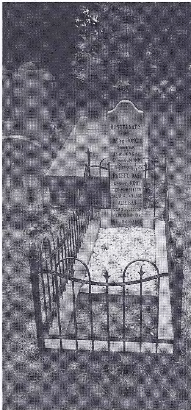
Na de restauratie
