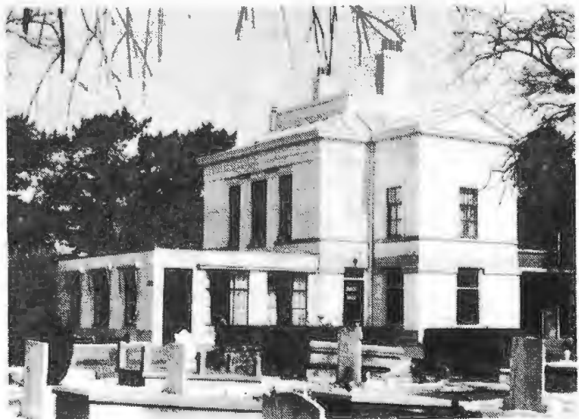
Het Schijndodenhuis aan de Kerkhoflaan (met aangebouwde serre, huidig kantoor).
