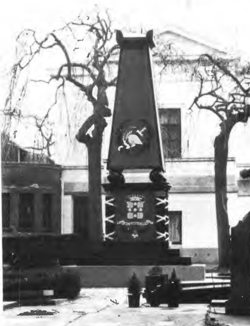
Te restaureren rijksmonument aan de Kerkhoflaan "Het Schijndodenhuis" met op de voorgrond de Citadel van Antwerpen.
