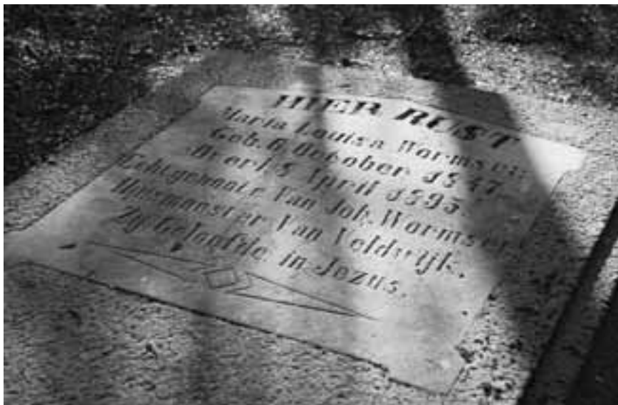
Op de oude begraafplaats een zerk van een huisbewaarster van kunststeen, cement met gemalen steen, met ingelegde marmere tekstplaat
