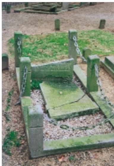
Steek in hardsteen is een veel voorkomend teken van verwerking en is een verschijnsel van drukontlading in de steen
