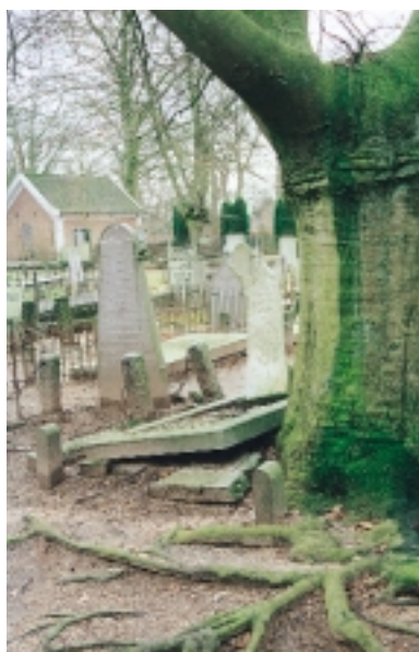
Gevaar voor breuk dreigt. Een gewapend betonnen roef, vrij van de wortels, zou breuk kunnen voorkomen
