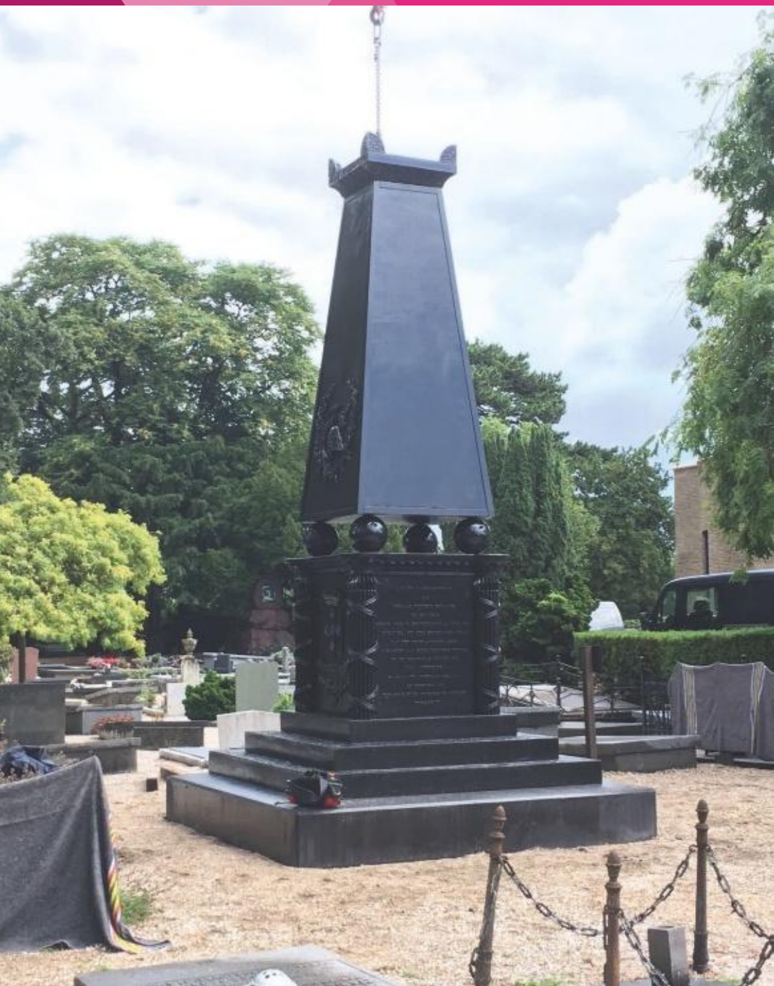
Terugplaatsen van het monument na restauratie in de smederij.
