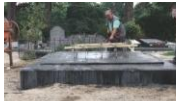
Nieuwe fundatie en RVS binnenwerk
